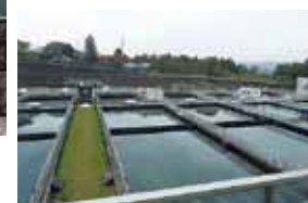
中津川浄水場
